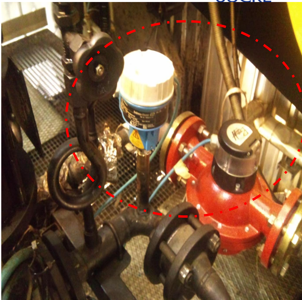
Figure 20 : Fuite vapeur PSL air SKID BH (montage d'un debimètre+ manomètre+elimination des fuites)
