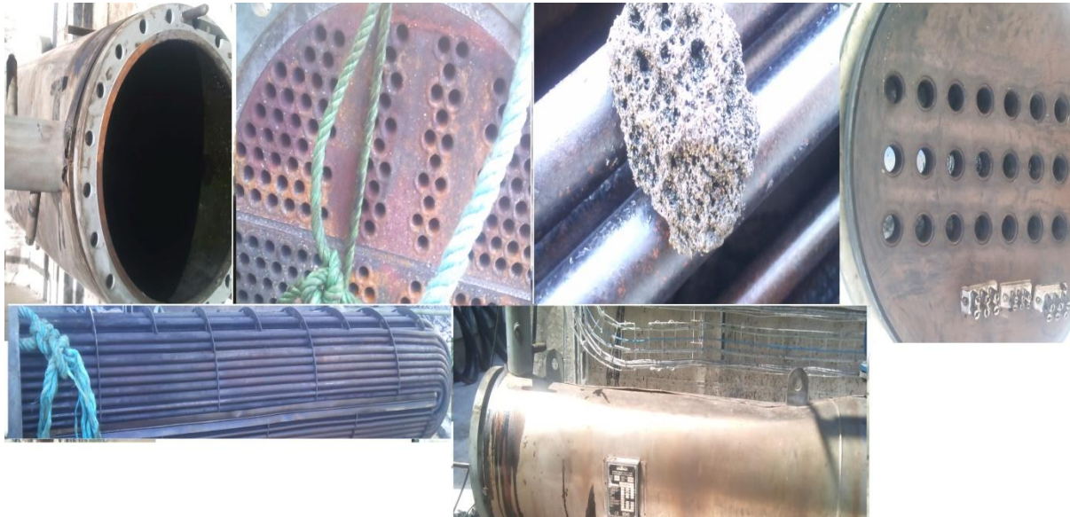
Figure 25 : nettoyage a l'intérieure de réchauffeur fuel
