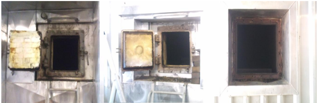
Figure 13 : chaudière, surchauffeur, économiseur
