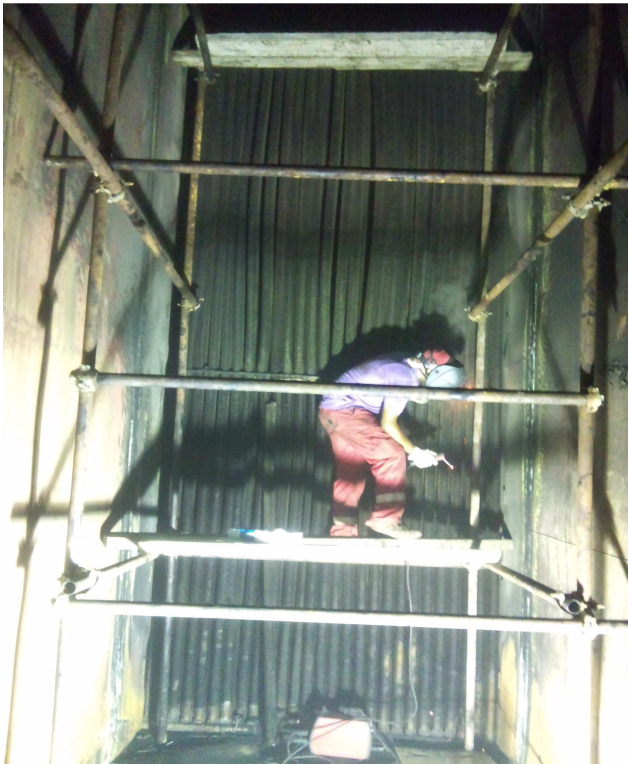
Figure 43 : opération en cours
