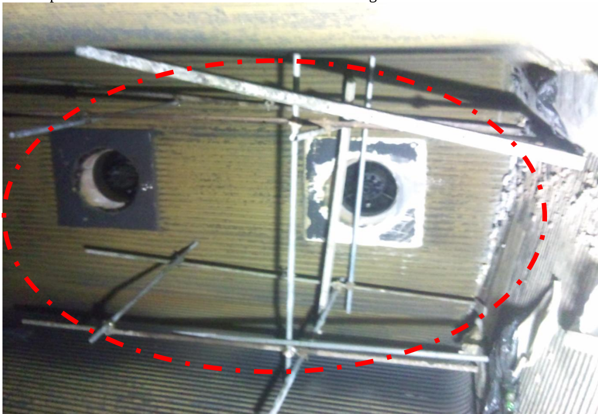
Figure 37 : montage échafaudage "chaudière"
