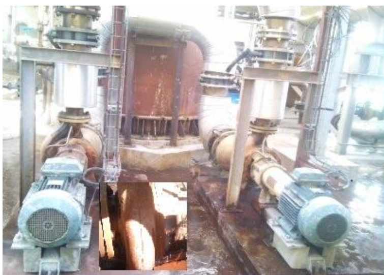
Figure 3 : Nettoyage des bouilleurs et recirculation avec acide sulfurique
