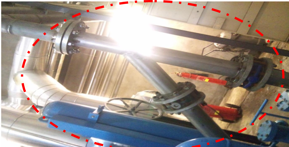
Figure 36 : montage des brides turbir
